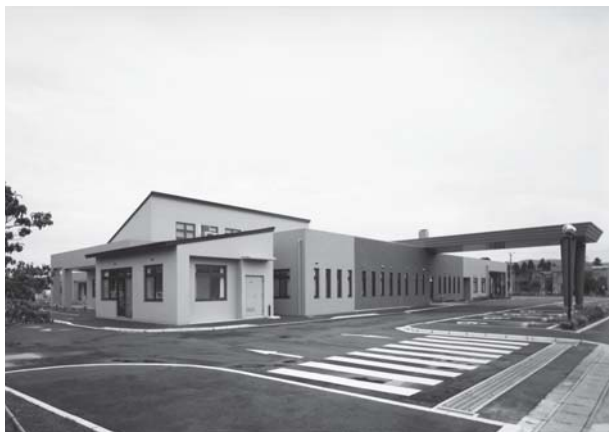
写真1：花水木外観 南西側
