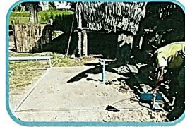
外側からセメントで 整えていきます
