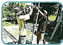
深く掘り進めます
