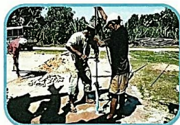
深く掘り進めます
