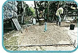
土台を均します
