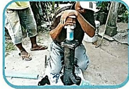
井戸部分を組み立てます
