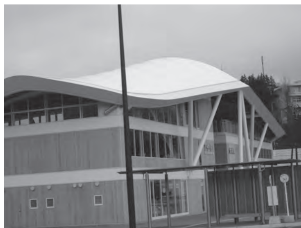
女川町の状況(2016年3月の状況)
