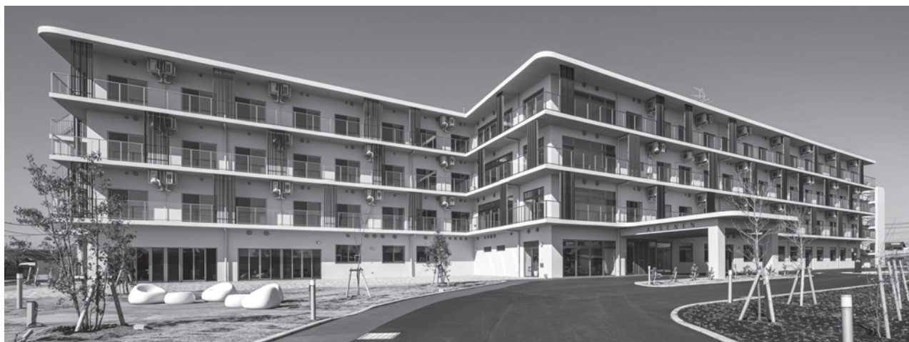
写真1 4階建ての全景
