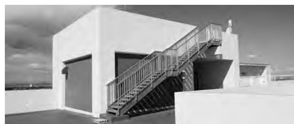
津波避難タワー
